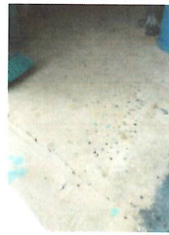
PISO, SUSTITUCION DE PISO DE GRANITO EN AREA DE COCINA POR PISO EN MAL ESTADO
