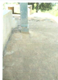
LOSA DE PATIO, REPARACION LOSA FRENTE A CORREDOR
