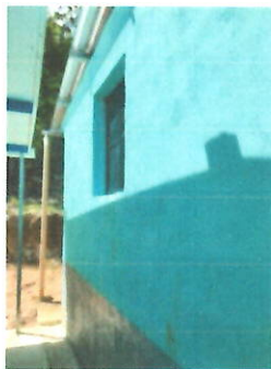
VENTANA, SUSTITUCION DE VENTANA EN AREA DE COCINA
